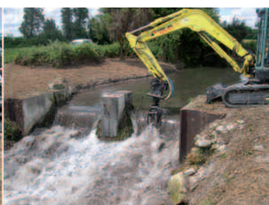
Seuil pendant travaux : retour à un écoulement libre 2008
