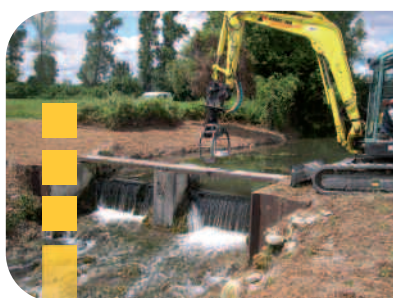
Seuil avant travaux : présence d'une retenue d'eau stagnante - 2008
