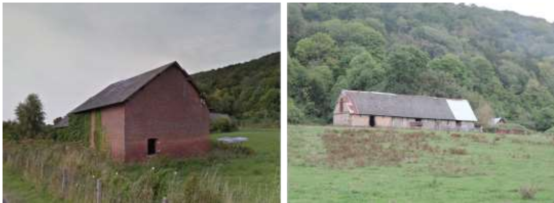
Exemple de bâtiments identifiés
