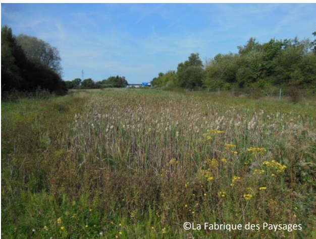
Photo 13 : Bassin de rétention SAPN le long de l'autoroute A13
