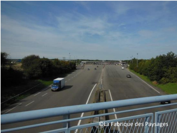
Photo 10 : Péage vu depuis le pont de la Route d'Ingremares
