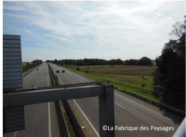
Photo 11 : Vue depuis pont de la Route d'Ingremares
