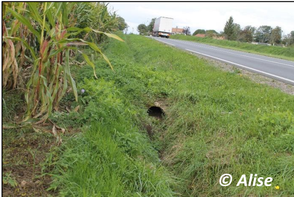
Photo 3 : Fossé situé le long de la RD 6 155
