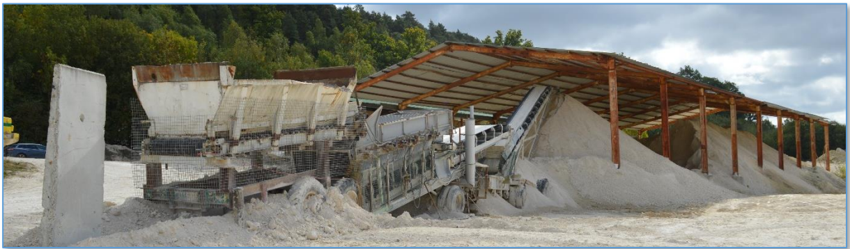
Fig. 34 : Vue B : Installation de criblage
