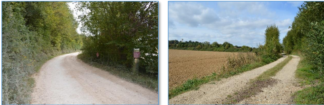
Fig. 24 : Vue sur les accès au site (respectivement Nord et Sud), fermés par des barrières (hors période d'activité)
