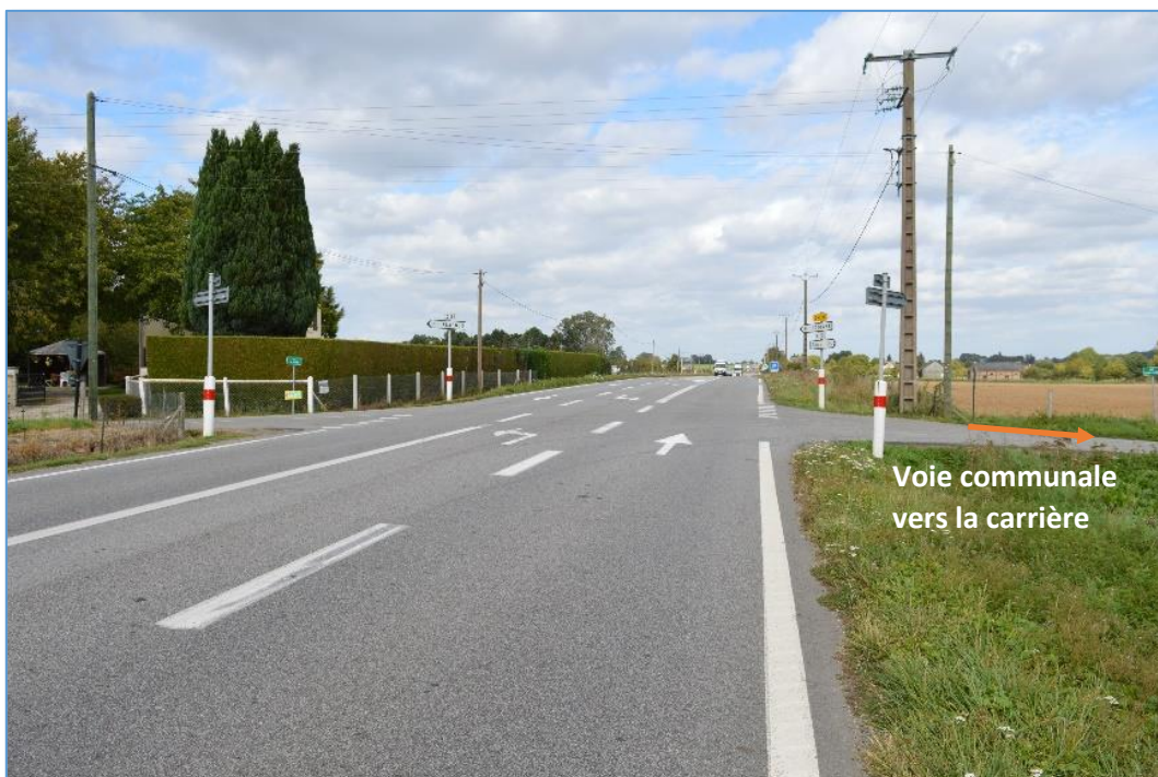
Fig. 17 : Vue n°6 sur la RD438
