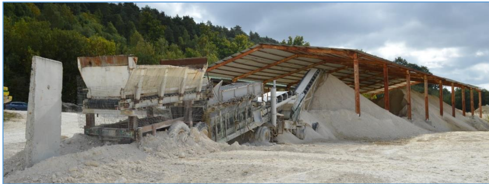
Fig. 56 : Vue sur la cribleuse et le hangar de stockage et séchage des marnes
