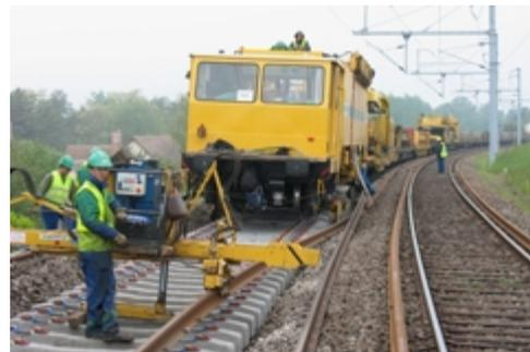
*Longs Rails soudés sur traverses béton*
