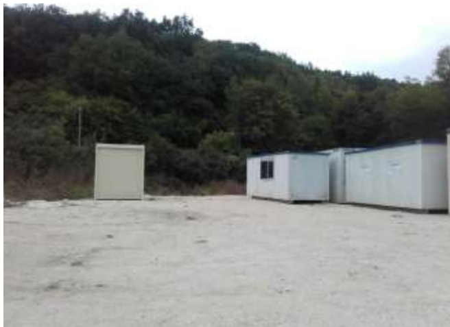
Photographie 2 : Carreau nettoyé, le béton et stockage d'algéco
