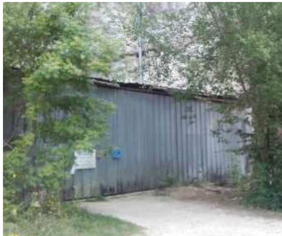
Photographie 3 : Hangar empêchant l'accès aux galeries
