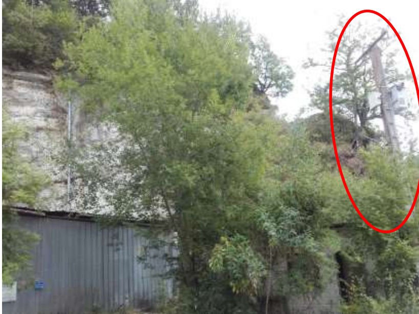
Photographie 7 : Poteau électrique à supprimer (Source : Visite de site du 13/09/2018)
