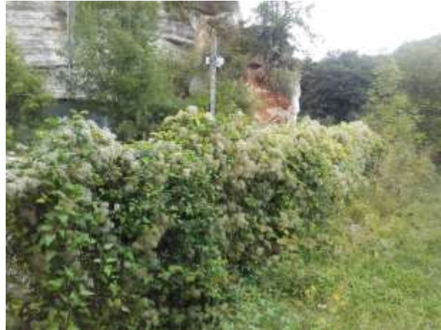
Photographie 4 : Clôture existante sur le site
