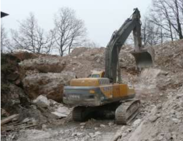
Photographie 7 : Décapage à la pelle hydraulique
