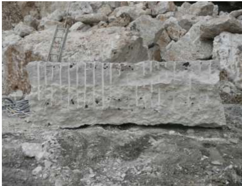
Photographie 9 : Perforations pour décollement par mortier expansif non explosif
