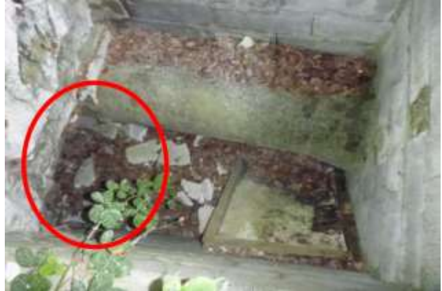
Photographie 20 : Entrée de la galerie du ventilateur
