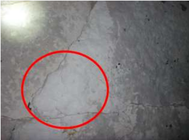
Photographie 13 : Dièdre au toit de la carrière
