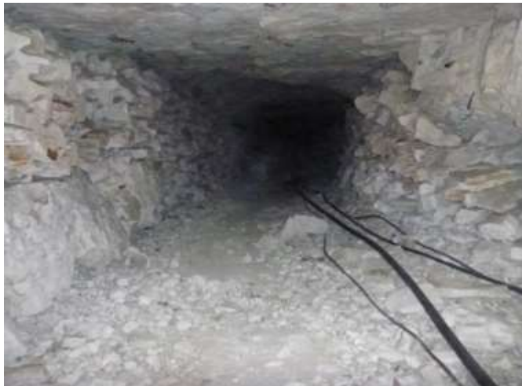
Photographie 21 : Murets de pierres dans la galerie du ventilateur
