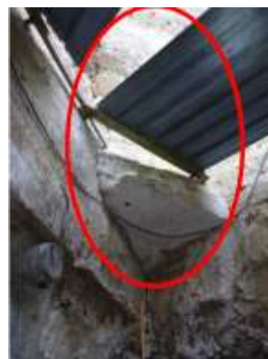
Photographie 4 : Dièdre de craie sur le front de taille
