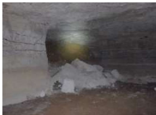
Photographie 6 : Remblais dans la galerie Ouest dans la zone d'exploitation de la société T.E.R.H.
