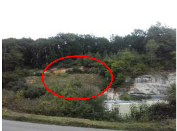
Photographie 27 : Après remise en état
