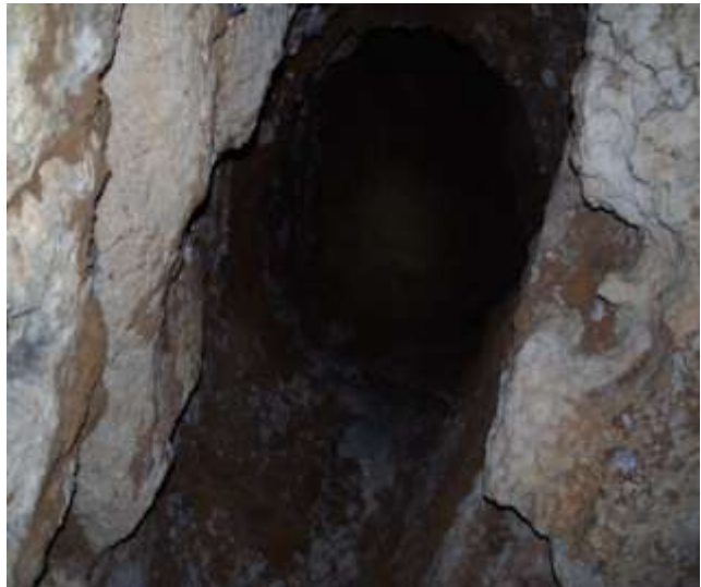
Photographie 10 : Montée de voûte dans le remplissage du karst
