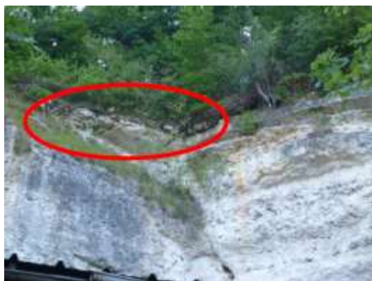
Photographie 3 : Petites pierres potentiellement instables
