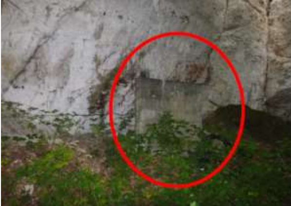
Photographie 19 : Emplacement de la galerie du ventilateur
