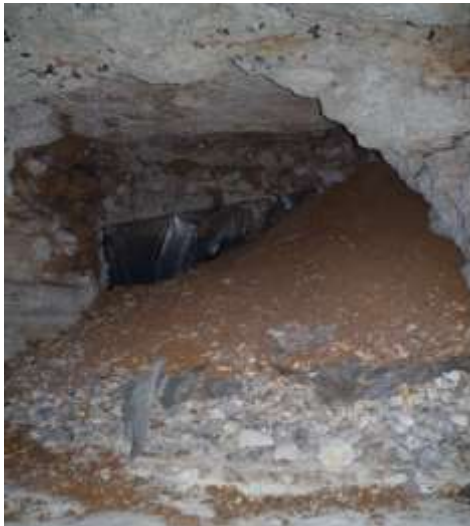
Photographie 9 : Débouillage du remplissage argileux du karst
