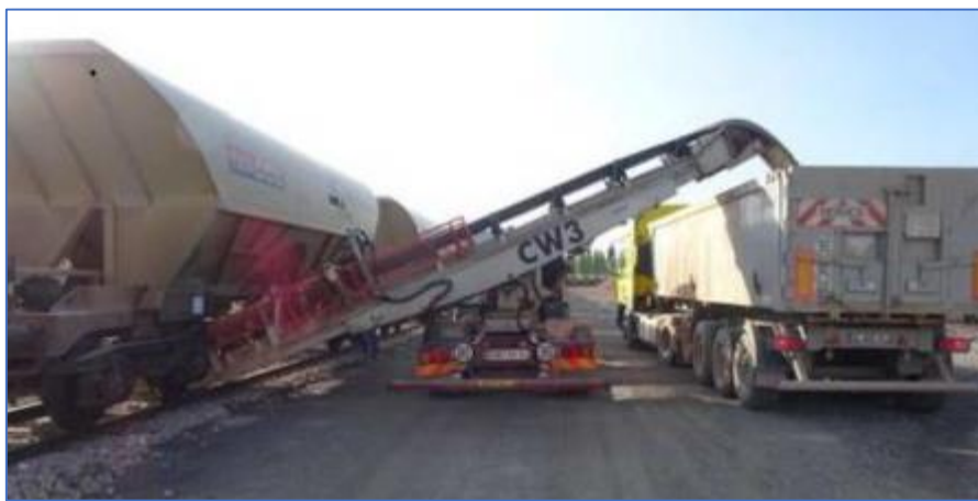
Fig. 57 : Exemple de déchargement de train par sauterelle mobile (Site Vignats de Petit Couronne)
