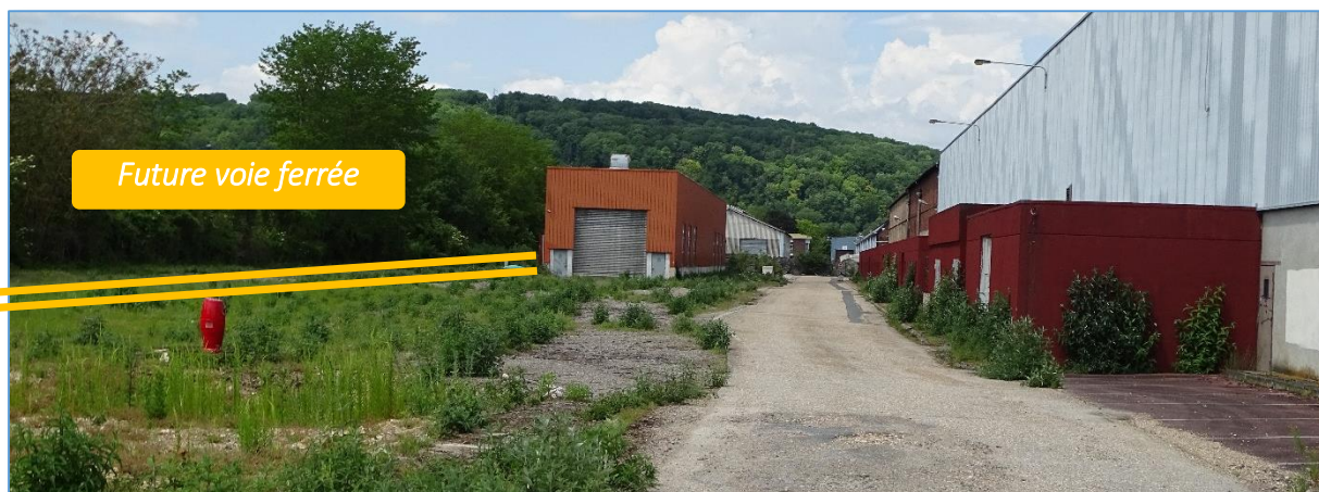
Fig. 46 : Vue n°9 : Espace Sud : future voie ferrée
