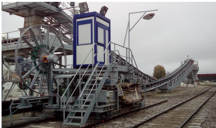
Figure 1 : Système de déchargement des wagons (Photo : Techmi)
