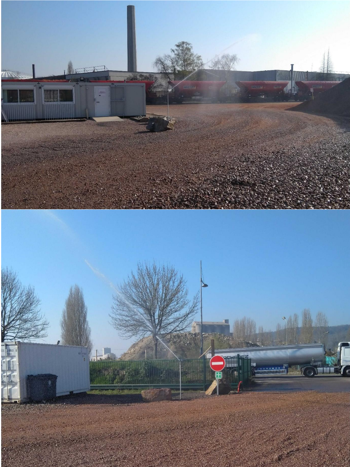
Fig. 41 : Système d'aspersion des pistes (exemple du site de Petit Couronne)
