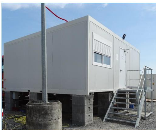
Figure 12 : Vue d'un bâtiment modulaire sur pilotis, source IGC.
