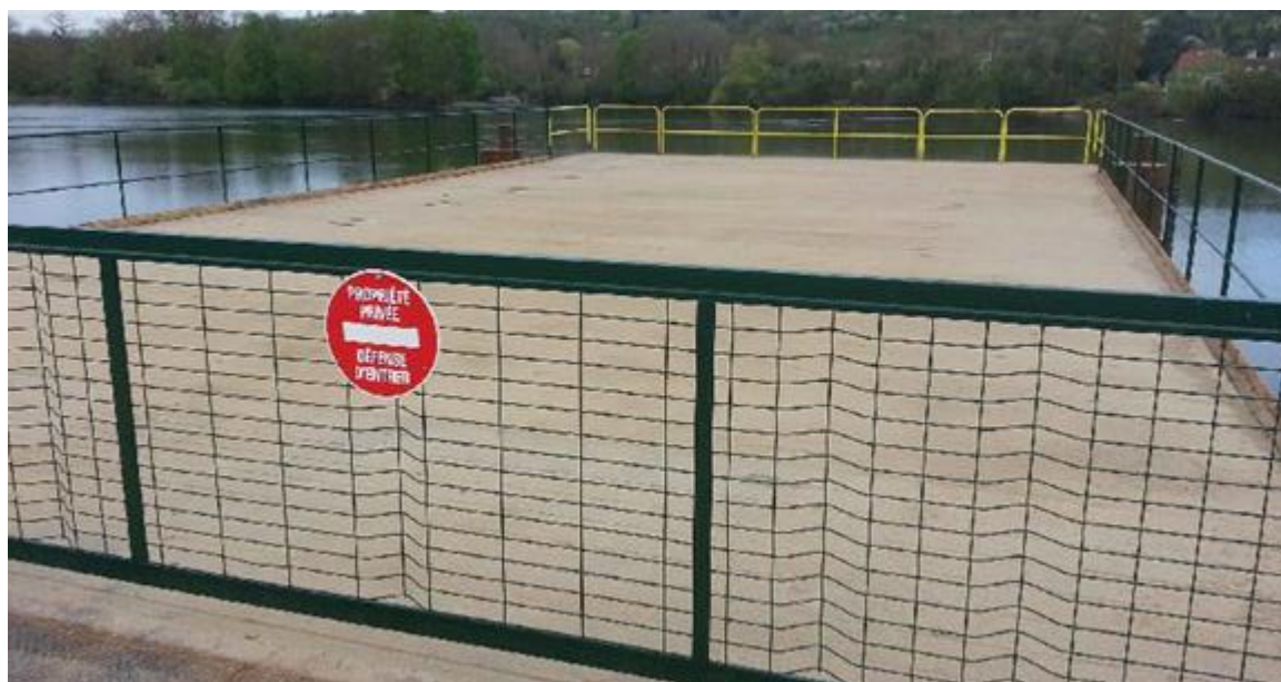
Fig. 8 : Vue sur les panneaux de prévention et rambardes sur une estacade (Source : Leduc)
