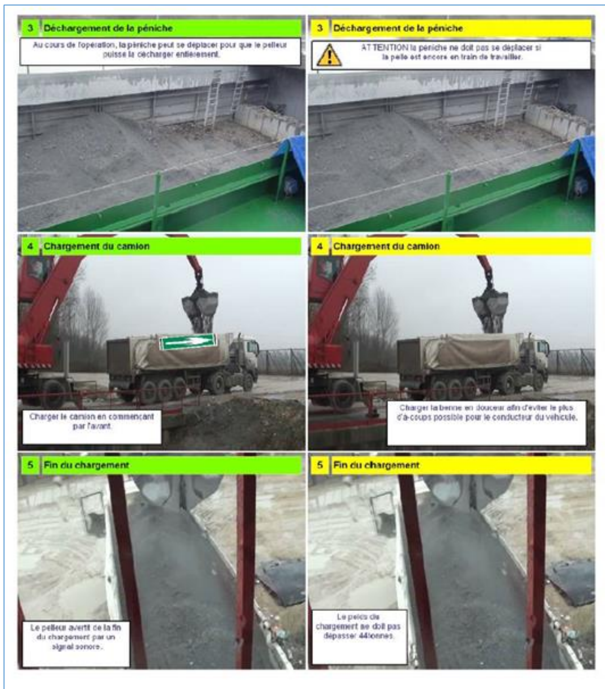
Fig. 4 : Mesures de prévention lors du chargement / déchargement des barges (source : FR Environnement)
