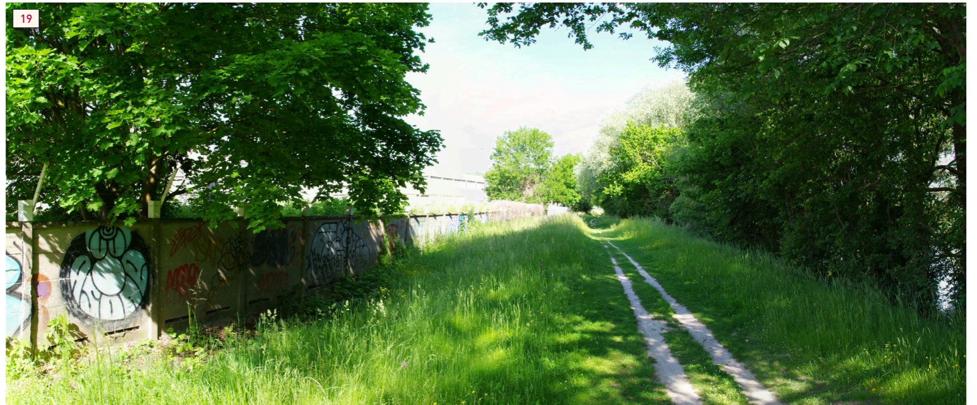
Aspect actuel du mur de clôture
