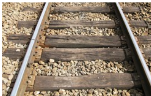
Rails courts sur traverses bois
