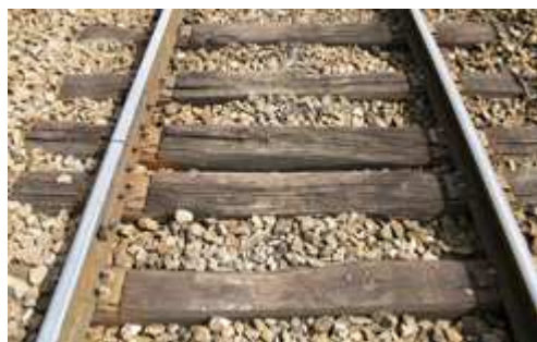
Rails courts sur traverses bois
