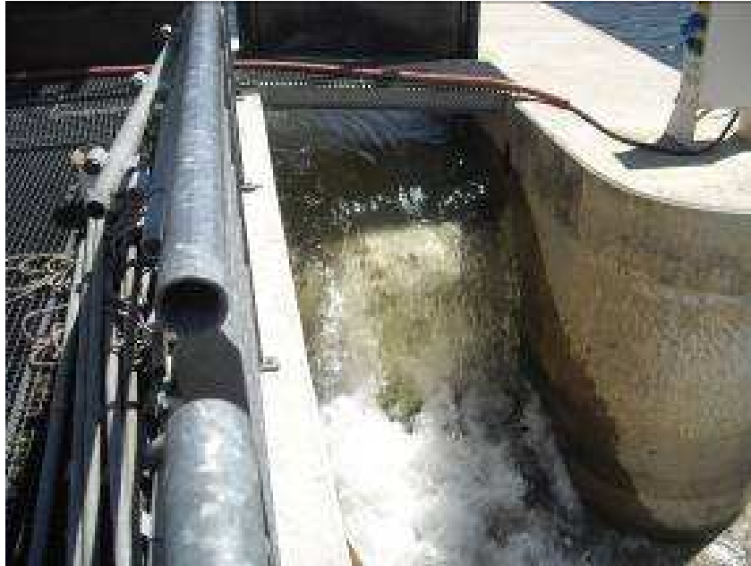
Figure 1 : Exemple de déversoir rectangulaire dénoyé.
