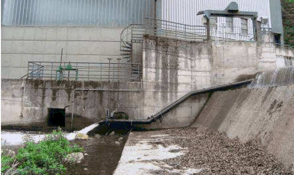
Figure 17 : Exemple de conduite en charge par syphon.
