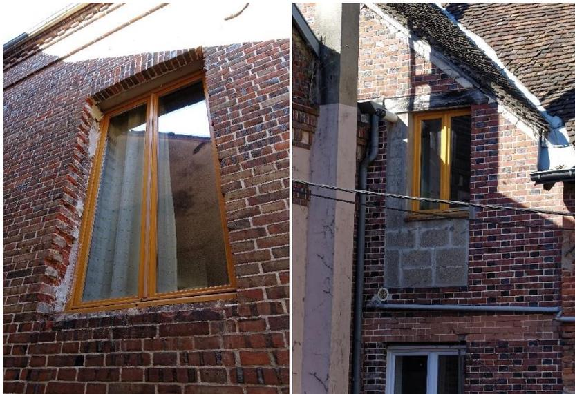
Dénaturation des baies pour s'adapter à des menuiseries industrielles : à gauche, rabotage de l'appui et des jambages ; à droite, comblement partiel en agglos nus
