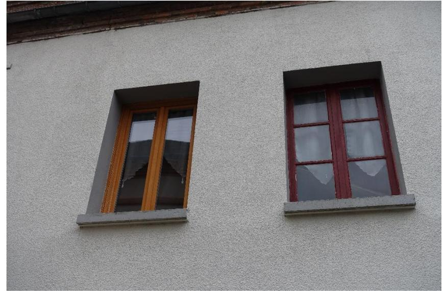
Pose d'une fenêtre « industrielle » en pin (couleur jaune orangé), sans petits bois ; on remarque une réduction de la surface vitrée liée à la pose dite « en rénovation », où le nouveau dormant est positionné dans l'ancien qui a été conservé
