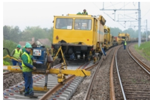
Longs Rails soudés sur traverses béton
