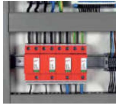
Le déconnecteur associé au parafoudre (fusible, disjoncteur ou déconnecteur intégré) a pour fonction d'assurer la continuité de service de la ligne protégée en fin de vie du parafoudre (qui doit tenir au moins 20 chocs de foudre, suivant la norme).
