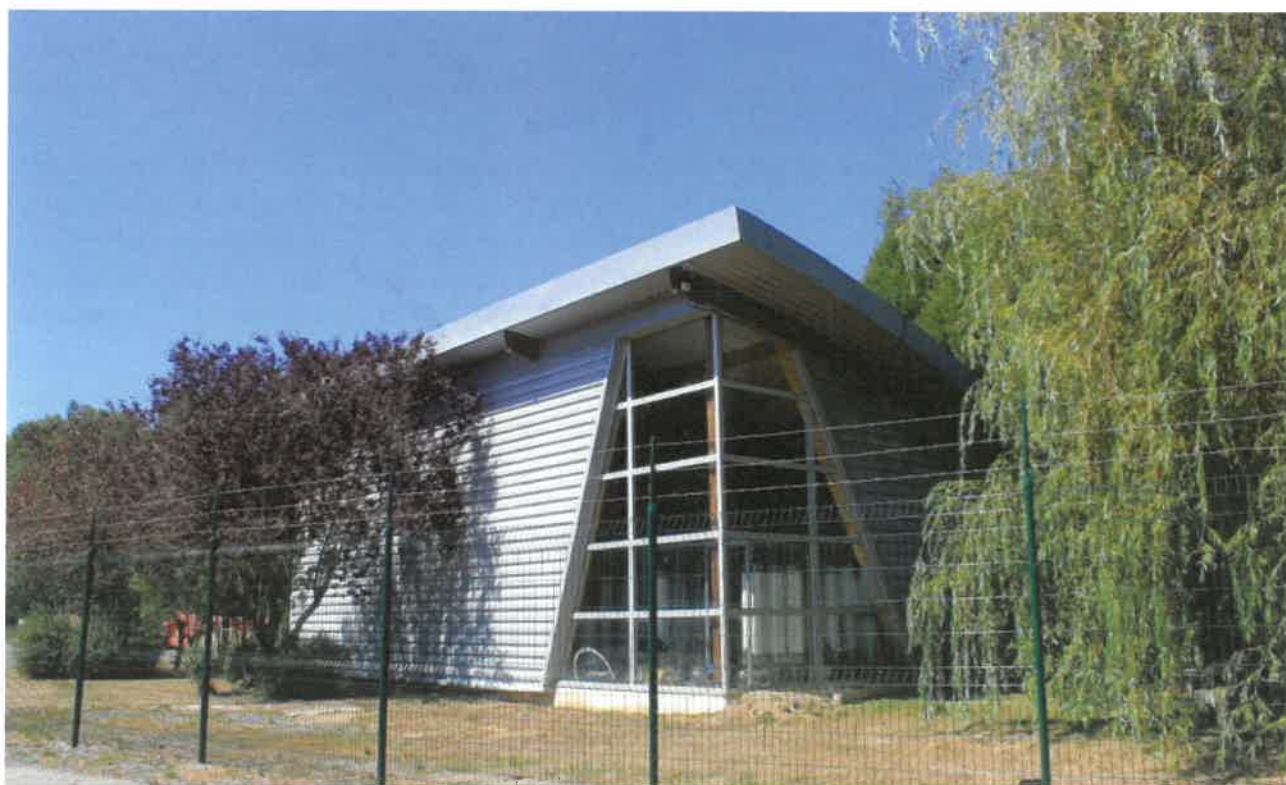
La station d'ultrafiltration du captage des Bruyères
